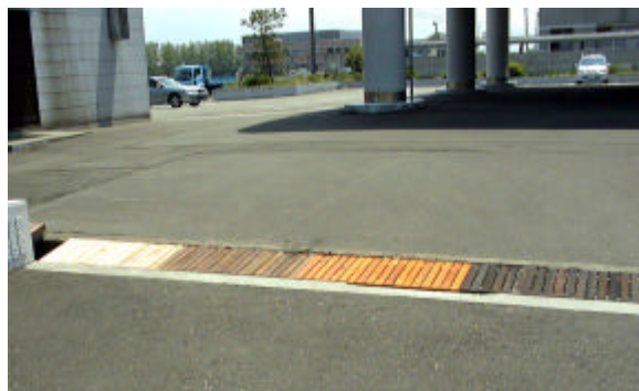
図2. 設置された試験体
