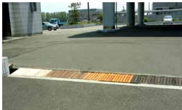
図1．設置され試験体
