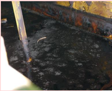
← 混合メッキ廃液タンクの液面を一様に覆う固化した浮上油
